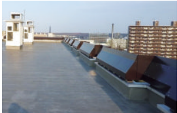
* 施工会社が特許をもつ雪庇（せっぴ）対策用設備を屋上の南側に設置
