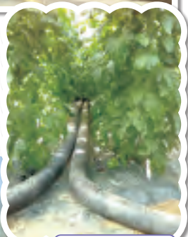
トマトハウスの温水ダクト。
